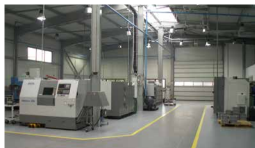
Hala produkcyjna Production hall
